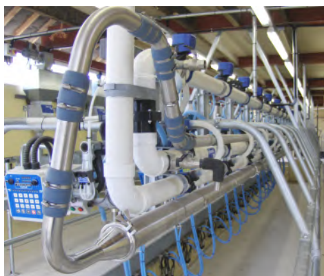
УСТАНОВКА ТРУБОПРОВОДОВ над доильной ямой
